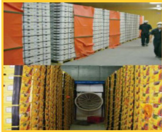
Conductos y túneles de enfriamiento con aire forzado.
